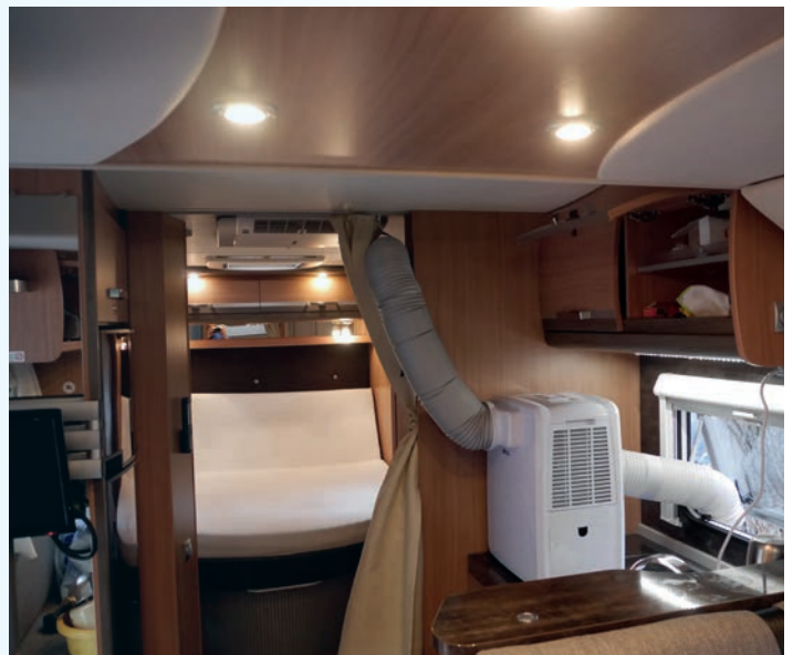
Klimatyzator wewnątrz kampera pompuje zimne powietrze do innego pomieszczenia. Gorące powietrze usuwane rurą na zewnątrz pomieszczenia.
