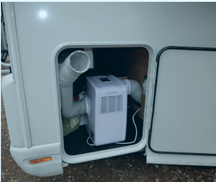
Klimatyzator pompuje zimne powietrze do wnętrza kampera z pomieszczenia technicznego. Gorące powietrze usuwane rurą na zewnątrz pomieszczenia.
